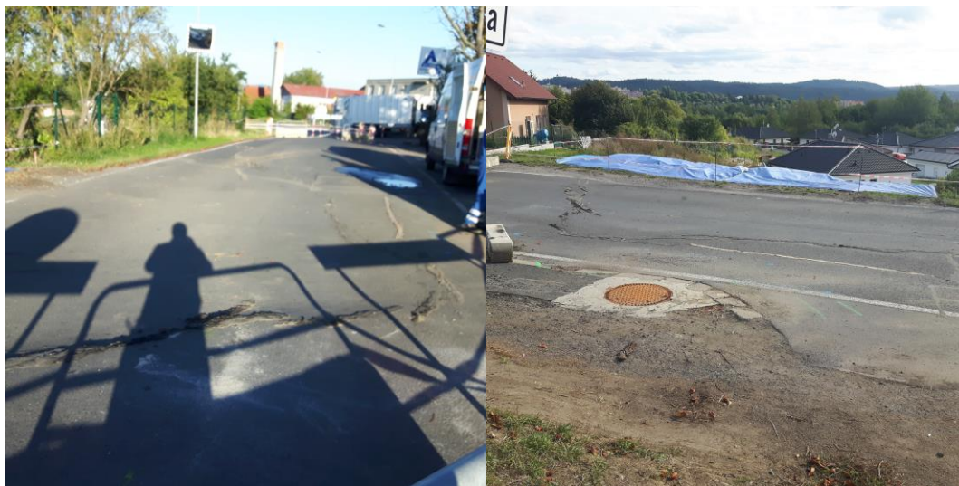
Obrázek 1 – Porucha (prosednutí) komunikace III/2201
